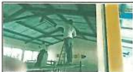
Foto 4: SUMINISTRO DE PINTURA EN ESTRUCTURA METÁLICA EXISTENTE
