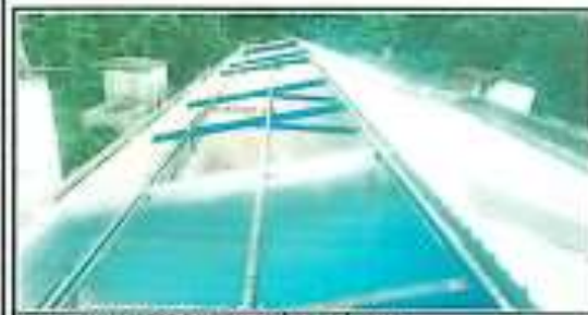
Foto 5: SUMINISTRO E INSTALACIÓN DE LÁMINAS
