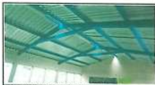
Foto 6: FINALIZA LA COLOCACIÓN DE LÁMINAS
