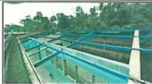
Foto 2: SUMINISTRO E INSTALACIÓN DE LÁMINA PRIMERA FASE
